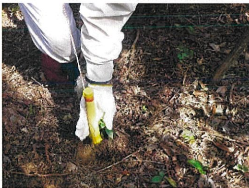
写真2. 3. 1-3 コンクリート破砕剤装填状況
